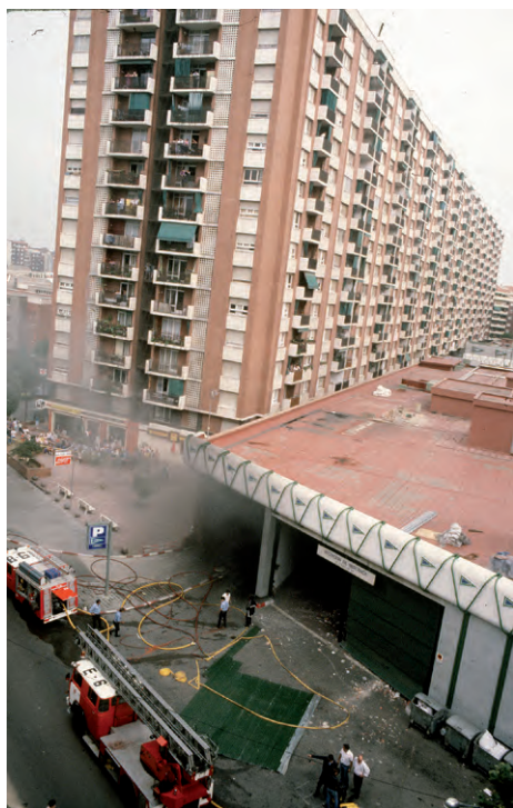
Los terroristas aparcaron el coche bomba en el estacionamiento subterráneo del edificio.
